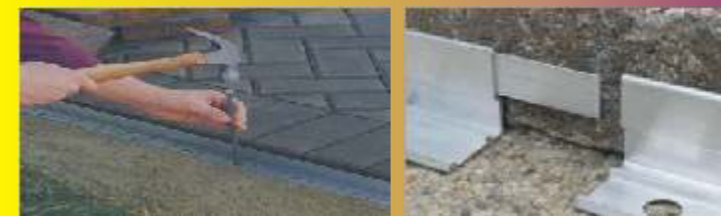
proste mocowanie obrzeża specjalne blaszki i czarne profile
