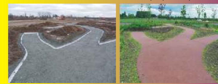
alejki w trakcie budowy efekt końcowy
